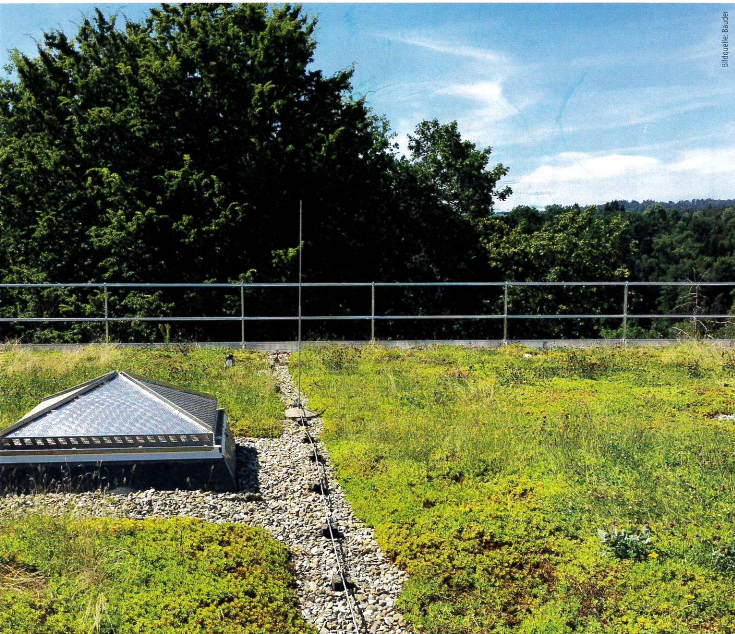
*Für jeden, der das Dach begehen muss, sicher die einfachste und sicherste Form, einen Absturz zu verhindern: das Geländer, umlaufend am Dachrand montiert.*
